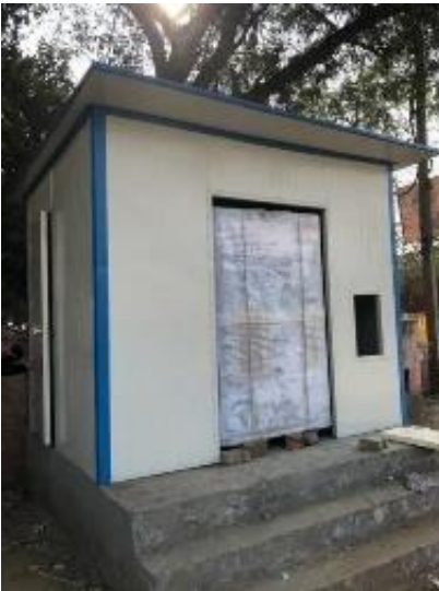
クリーンルーム
